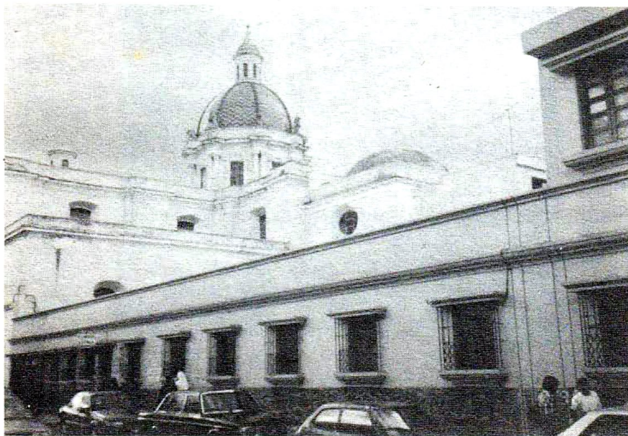
Edificio de Servicios Sociales de La Merced.
